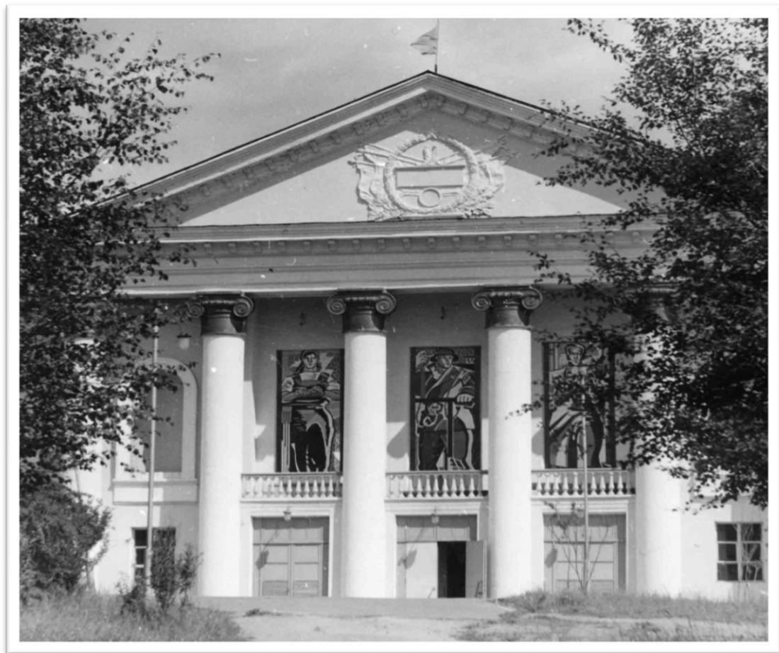
Дом культуры г. Бодайбо. Дата съемки: 1987 г. Место съемки: Бодайбо, Иркутская область. Основание: Фотофонд: № 4512 ч-бп.
