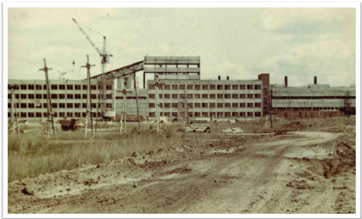
Строящийся завод железобетонных изделий. Строительство начато в 1980 г. Дата съемки: 1982 г. Место съемки: г. Тайшет. Основание: Фотофонд. № 56 ц-п.
