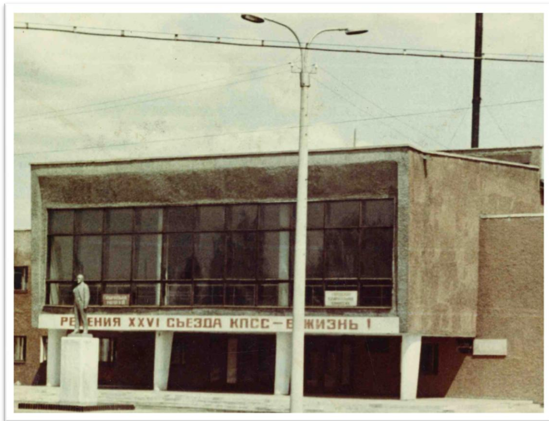
Городской дом культуры. Объект сдан в эксплуатацию в 1979 г. Дата съемки: 1982 г. Место съемки: г.Тайшет.
