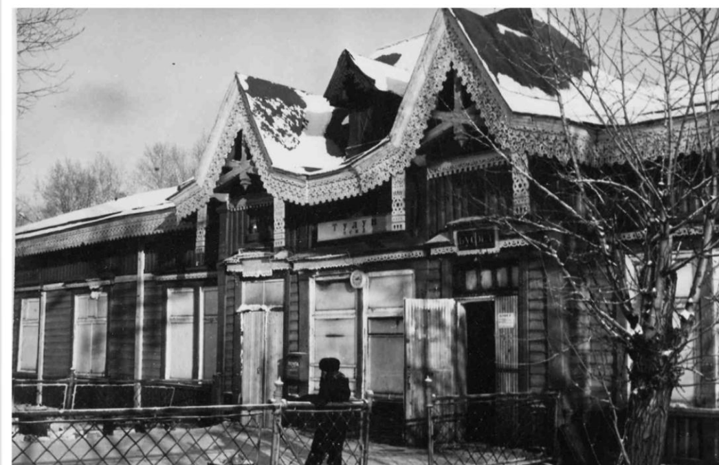
Здание железнодорожного вокзала станции Тулун. Дата съемки: 1989 г. Место съемки: Тулун. Основание: Фотофонд. № 4877 ч-бп.
