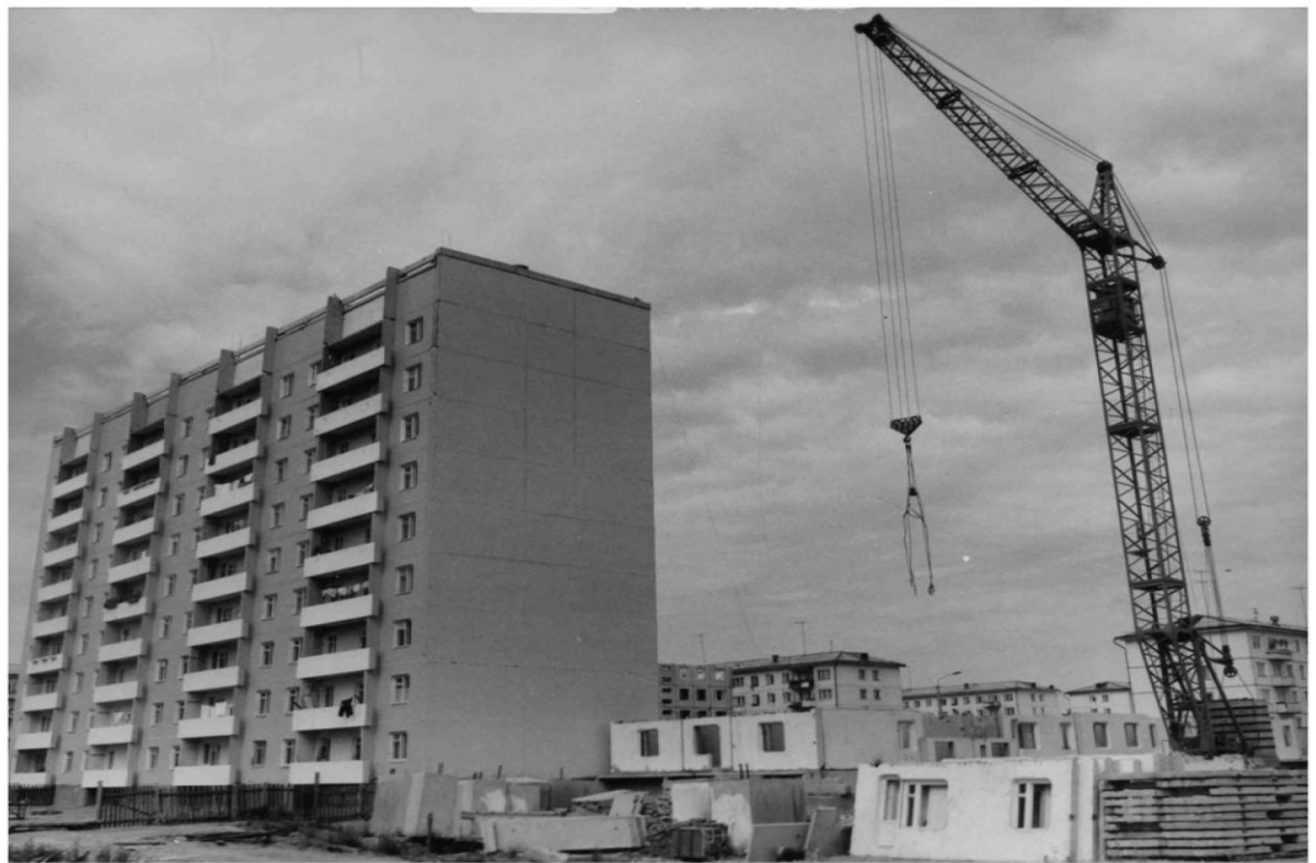
Строительство первых девятиэтажных жилых домов. Дата съемки: 1983 г. Место съемки: Усолье-Сибирское.
